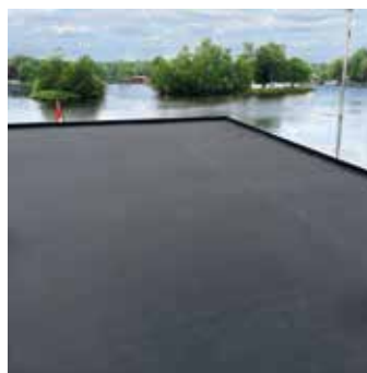
40.9991 Couverture de toiture en EPDM 1.14 mm d'épaisseur sur dimension par m 2
